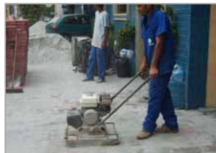
5 Espalhamento de areia de rejuntamento e compactação final
